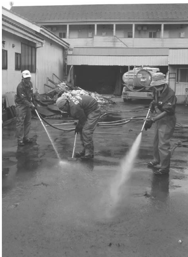
泥で汚れた路面を洗浄
