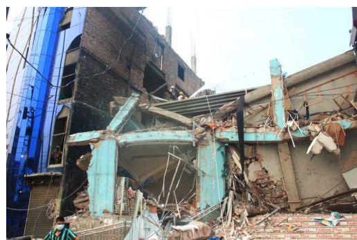
サバルで倒壊したビルの一部
